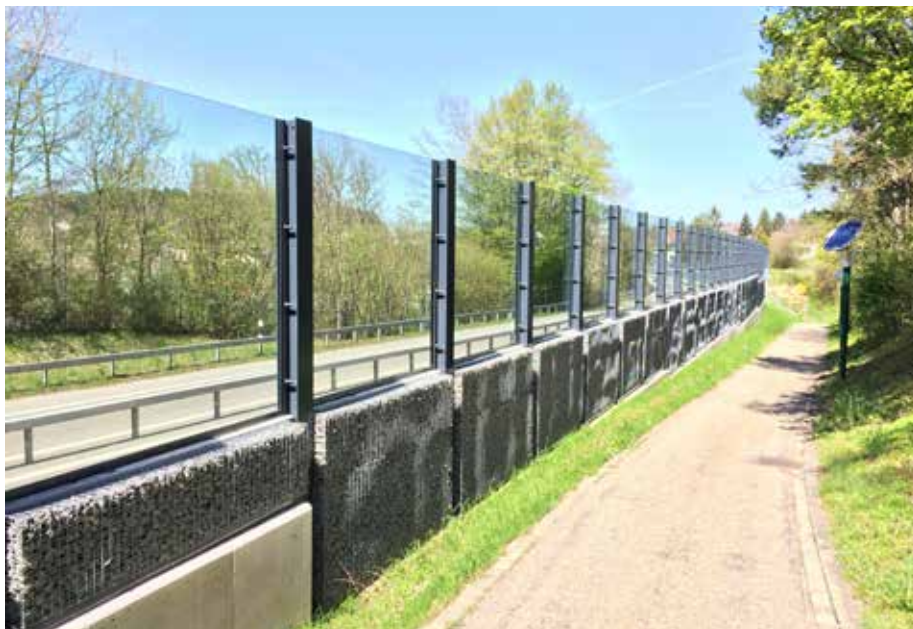
Die Sicht der Anwohner auf die Landschaft bleibt erhalten. Das Punkteraster auf der Lärmschutzwand verschwindet optisch.
