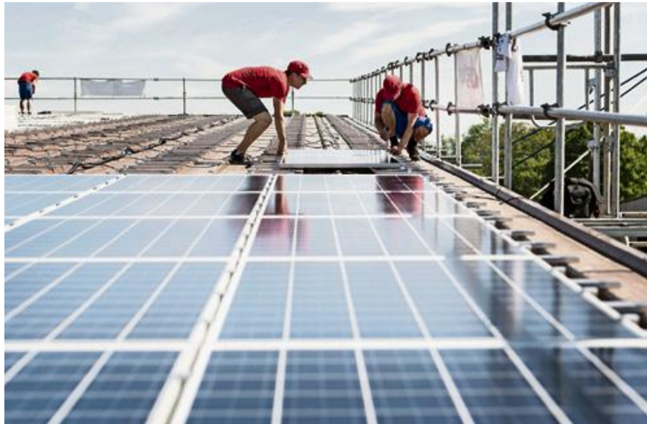
Auf den Dächern der Horgner Schulhäuser Tannenbach und Rainweg werden noch dieses Jahr Fotovoltaikanlagen installiert. Bild: key
