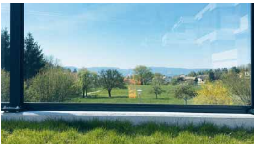
Die Sicht der Anwohner auf die Landschaft bleibt erhalten. Das Punkteraster auf der Lärmschutzwand verschwindet optisch. Quelle: TBA
