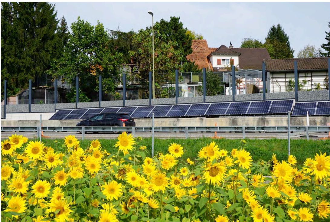
PV Anlage der Zürichsee Solarstrom AG an der Lärmschutzwand in Zumikon.
